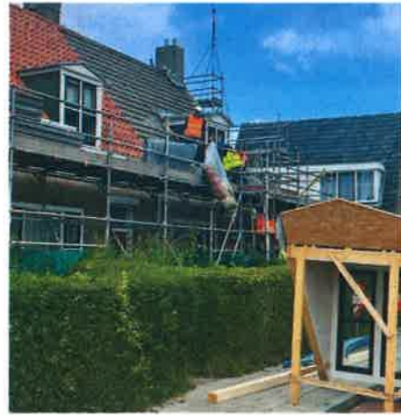
Vervangen dakkapellen Kimswerderweg
