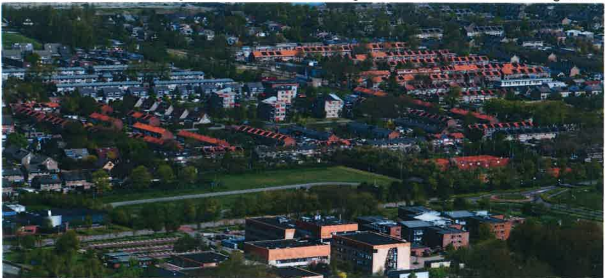
Luchtfoto zonnepanelen Harlingen
