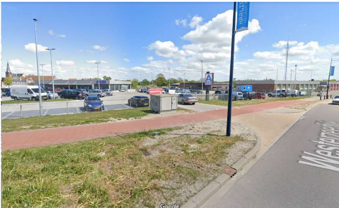
Figuur 2.1 Het noordelijke gedeelte van het Westerzeedijkgebied (bron: Street View)
